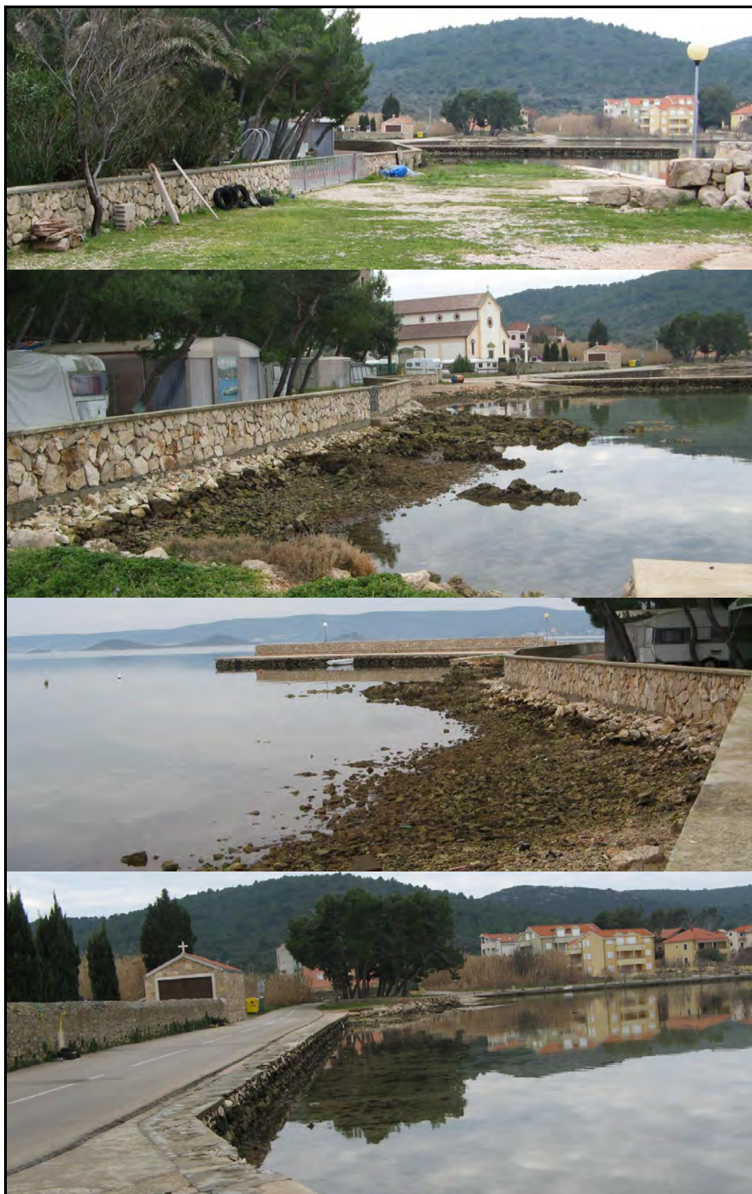
Slika 2.1-10. Postojeće stanje lokacije zahvata - zapadni dio lokacije zahvata, područje buduće dionice šetnice između luke i groblja
