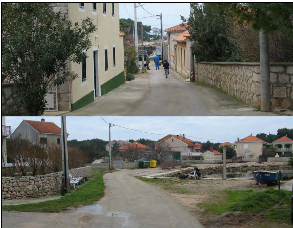
Slika 2.1-8. Postojeće stanje lokacije zahvata: a) prilazna cesta do lokacije zahvata (nije predmet zahvata) i, b) obalna cesta koja će se rekonstruirati u sklopu zahvata
